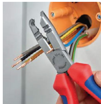
Обрезка отдельных проводов
