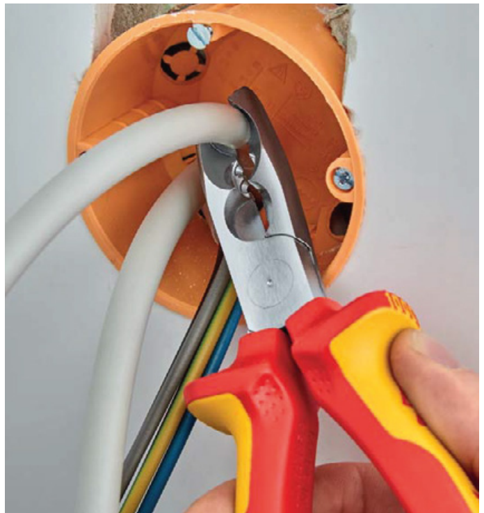
Удаление оболочки с провода в глубине монтажной коробки для скрытой проводки
